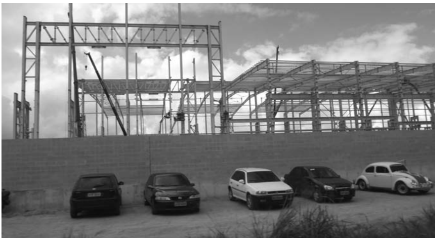
Estruturas do estaleiro Jurong
